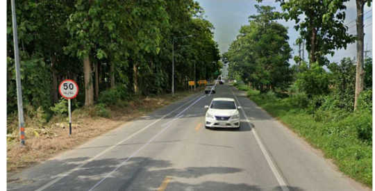
จุดเริ่มต้นโครงการ (ตอนที่2) ทล.3394 ประมาณ กม.8+780
