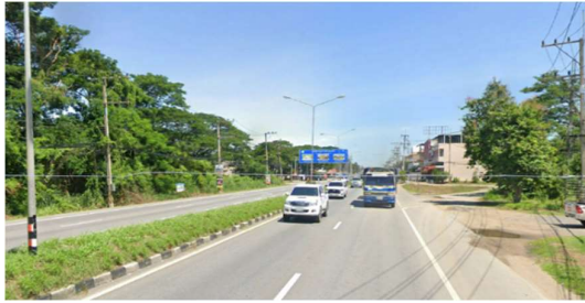
จุดเริ่มต้นโครงการ (ตอนที่1) ทล.323 ประมาณ กม.17+800
