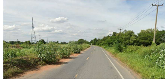
จุดตัดถนนโครงการ (ทล.3261 ประมาณ กม.29+000)
