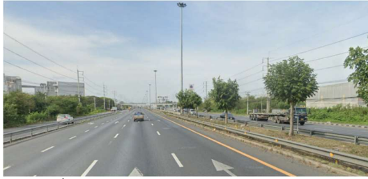
จุดเริ่มต้นโครงการ (ทล.1 ประมาณ กม.82+600)
