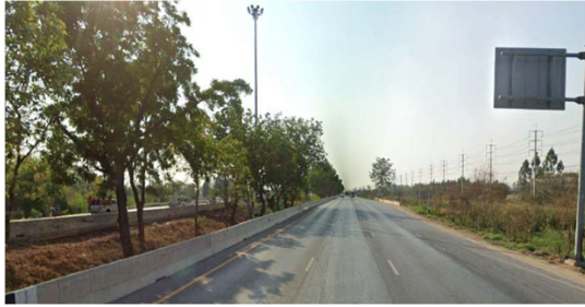
จุดเริ่มต้นโครงการ (ทล.32 ประมาณ กม.25+000)
