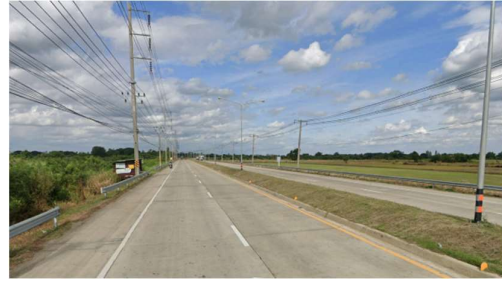
จุดตัดถนนโครงการ (ทล.33 ประมาณ กม.59+800)
