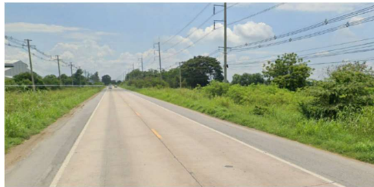
จุดตัดถนนโครงการ (ทล.3267 ประมาณ กม.21+500)
