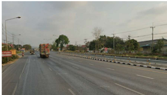
จุดเริ่มต้นโครงการ (ทล.1 ประมาณ กม.120+980)
