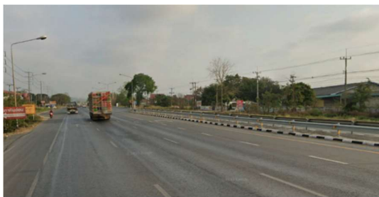
จุดเริ่มต้นโครงการ (ทล.1 ประมาณ กม.120+980)
