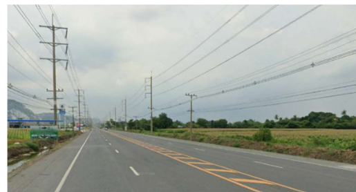
จุดตัดถนนโครงการ (ทล.3034 ประมาณ กม.7+250)
