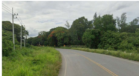
จุดตัดถนนโครงการ (ทล.3224 ประมาณ กม.5+200)
