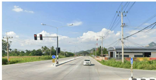
จุดตัดถนนโครงการ (ทล.3022 ประมาณ กม.22+570)
