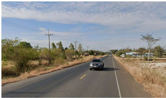
จุดเริ่มต้นโครงการ (ทล.2169 ประมาณ กม.29+230)
