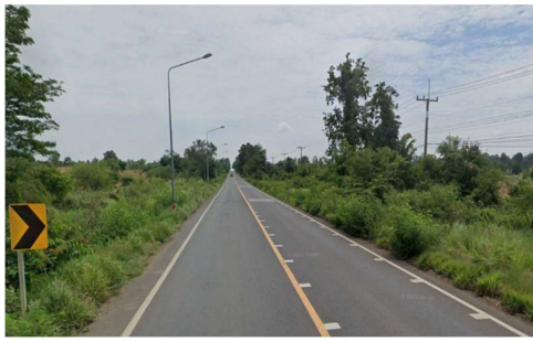
จุดตัดถนนโครงการ (ทล.348 ประมาณ กม.111+200)
