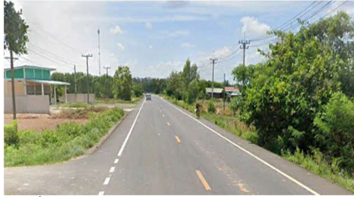
จุดเริ่มต้นโครงการ (ทล. 224 ประมาณ กม.130+860)
