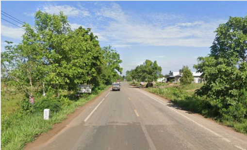
จุดตัดถนนโครงการ (ทล.224 ประมาณ กม.113+800)
