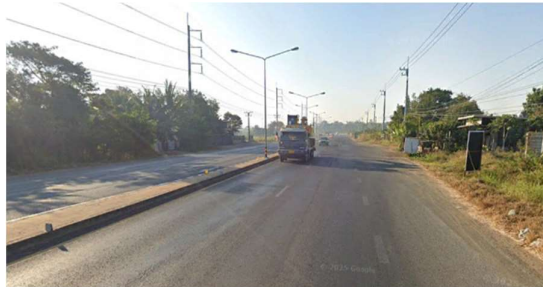
จุดตัดถนนโครงการ (ทล.224 ประมาณ กม.35+750)
