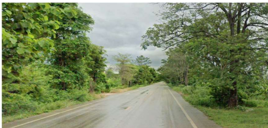
จุดตัดถนนโครงการ (ทล.1303 ประมาณ กม.15+300)
