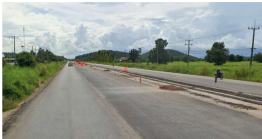
จุดเริ่มต้นโครงการ (ทล.101 ประมาณ กม.47+600)
