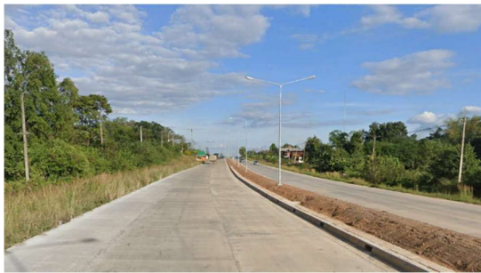
จุดเริ่มต้นโครงการ (ทล.210 ประมาณ กม.79+580)
