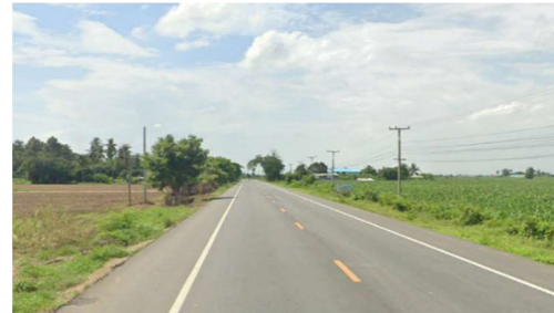
จุดตัดถนนโครงการ (ทล.1084 ประมาณ กม.59+800)
