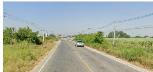
จุดตัดถนนโครงการ (ทล.1280 ประมาณ กม.38+200)
