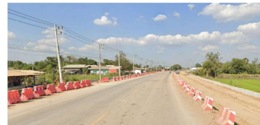
จุดตัดถนนโครงการ (ทล.1074 ประมาณ กม.29+500)
