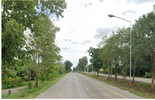
จุดเริ่มต้นโครงการ (ทล.1 ประมาณ กม.686+500)
