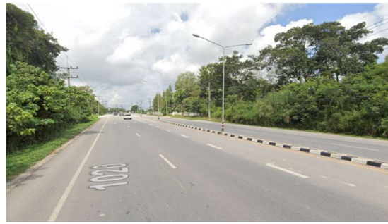
จุดตัดถนนโครงการ (ทล.1020 ประมาณ กม.5+400)
