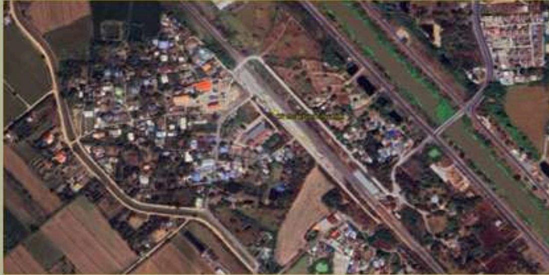
Container Yard สถานีบ้านป่าหวาย
