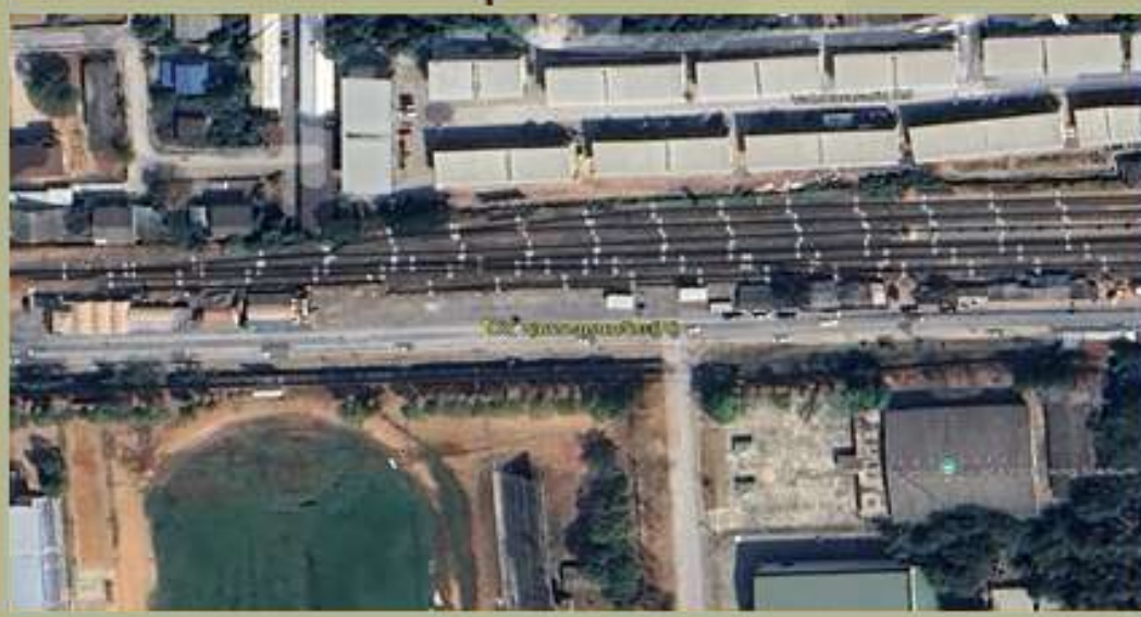
อยู่ระหว่างก่อสร้าง ทางคู่ สาย มาบกะเบา-ชุมทางถนนจิระ
